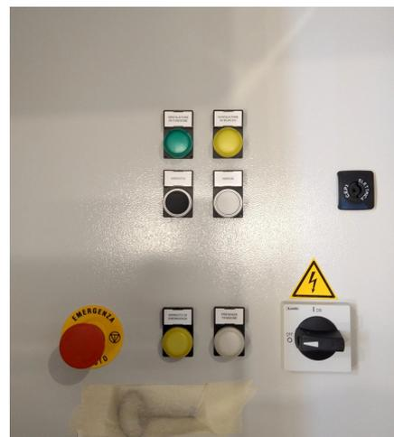
● **Quadro elettrico industriale** ad avviamento diretto e stella-triangolo, per avviamento e protezione motori ventilatori con alimentazione 3F+T 400Vac 50/60Hz.
