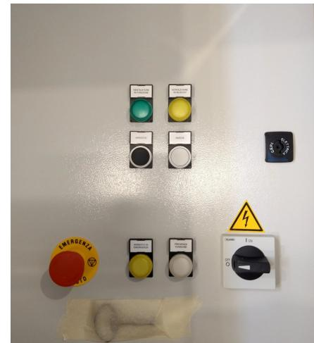
**Tableau industriel** avec démarrage direct et étoile-triangle, pour le démarrage et la protection des moteurs de ventilateurs avec alimentation 3F+E 400Vac 50/60Hz.
